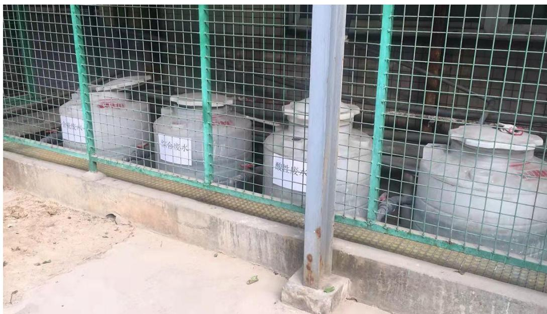
图 7.1-2 废水分类收集罐照片
